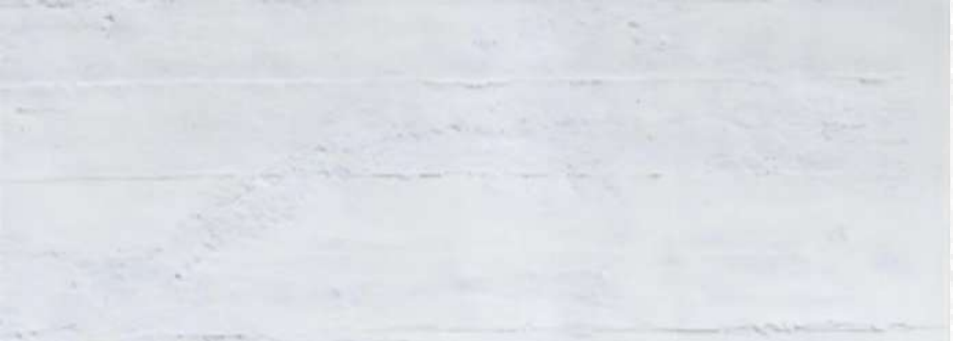
CEMENT POURING BORD-YM-JZ003
