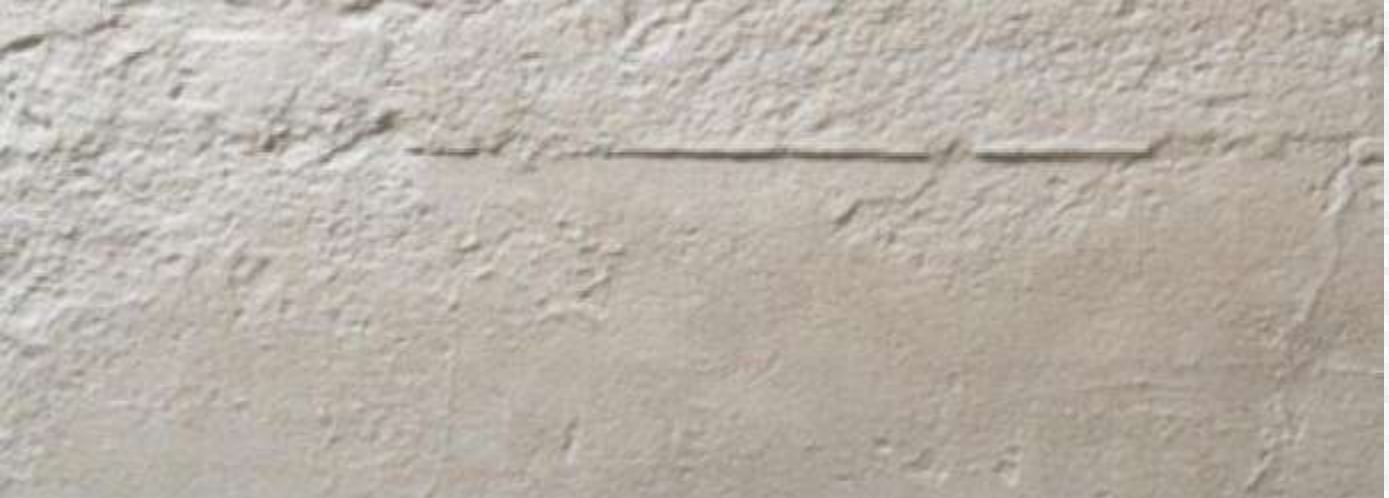
CEMENT POURING BORD-YM-JZ002
